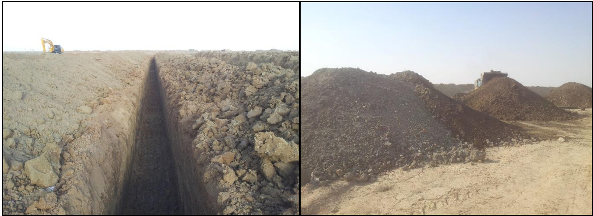
تصاویر شماره ۹- چگونگی گود برداری (کانال برداری)
